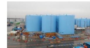
(溶接型タンク設置状況)
