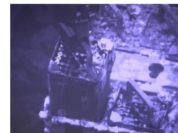
燃料取り出しの状況 (撮影日2019年4月15日)
