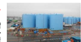
(溶接型タンク設置状況)
