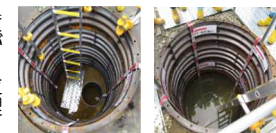
(陸側遮水壁) 内側 (陸側遮水壁) 外側
