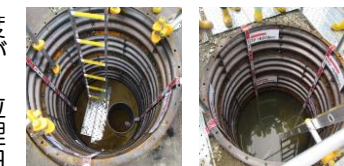
(陸側遮水壁) (陸側遮水壁) 内側 外側
