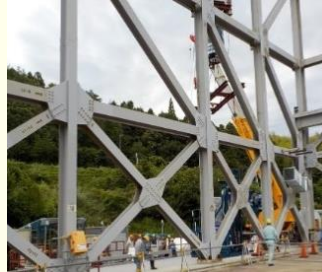
モックアップ試験の状況
