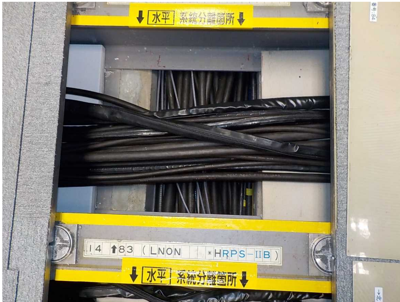
本日作業前の状況(2017年10月26日撮影)
