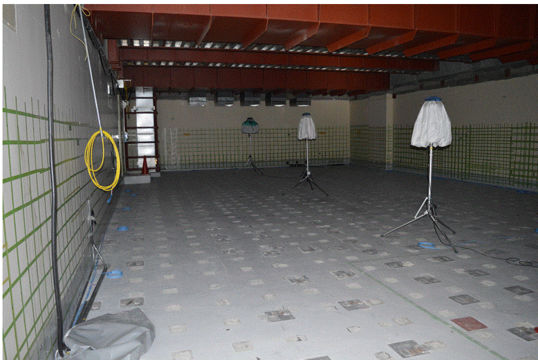
緊急時対策所の工事状況
