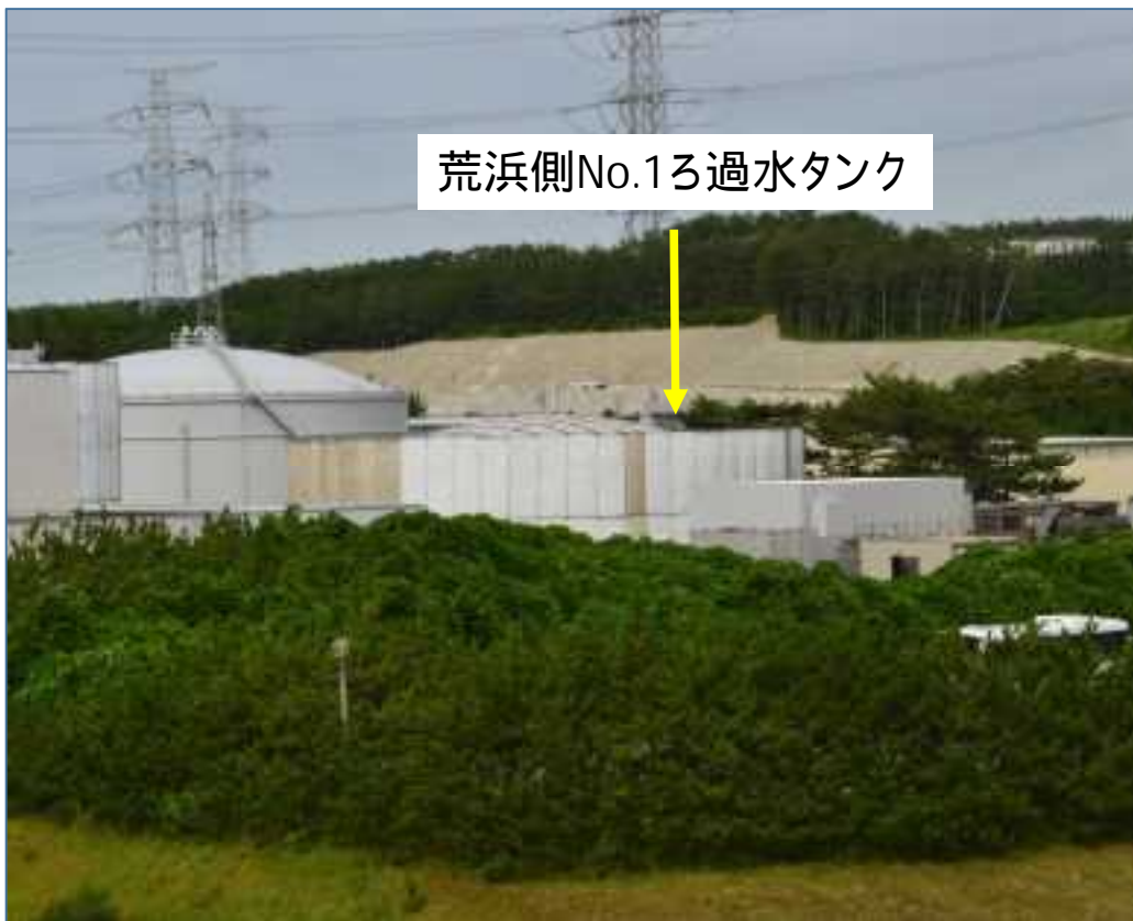
ろ過水タンク全景
