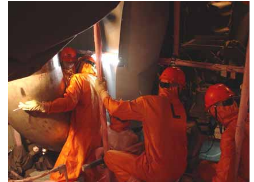
配管内部の最終確認を実施している状況（2号機の例）
