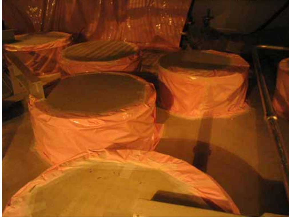
ベント管養生の状況
