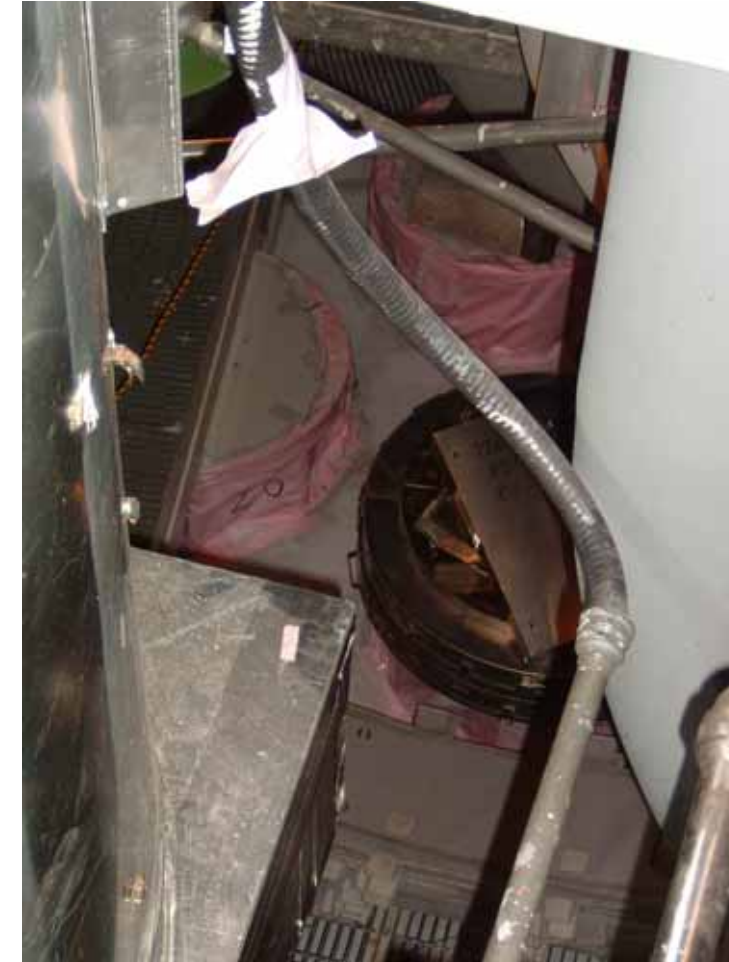
ベント管養生の状況
