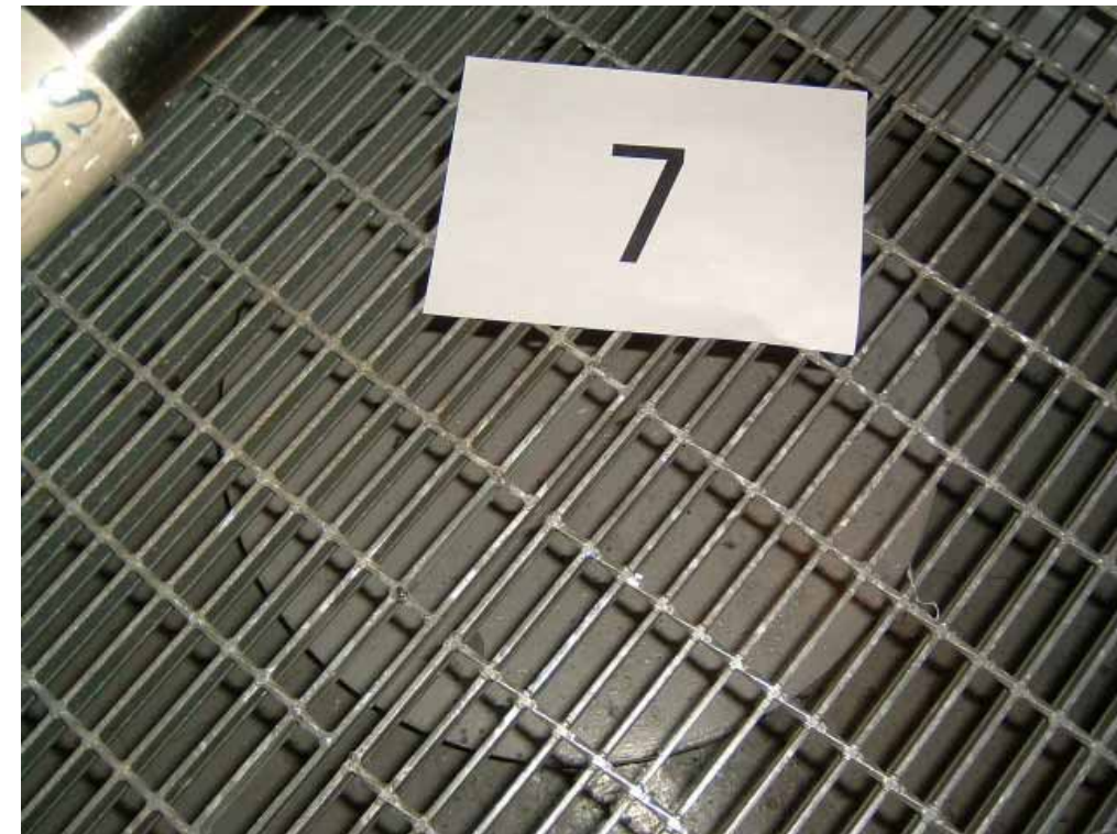
グレーチング下のベント管の状況
