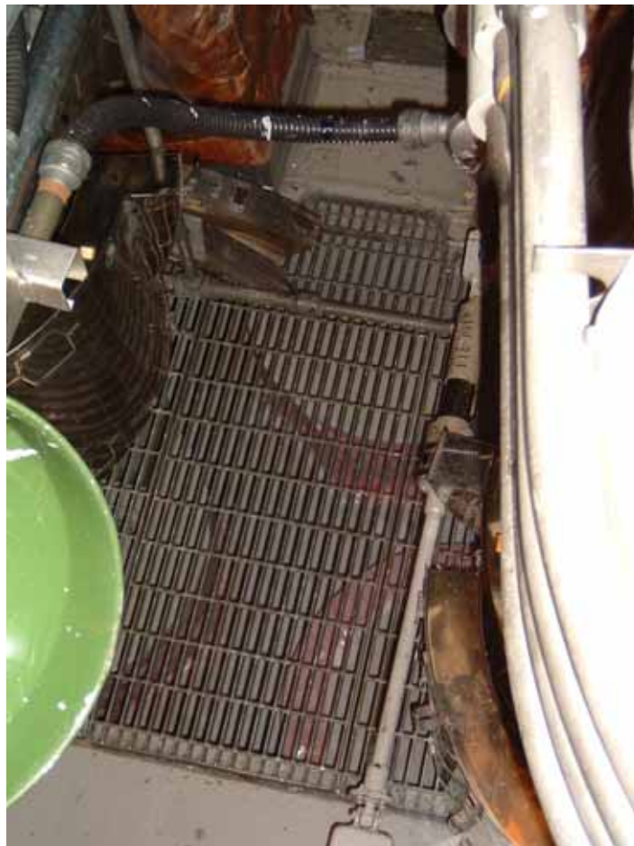
グレーチング下のベント管の状況
