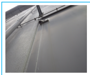
扉と枠の隙間をコーキング処理
