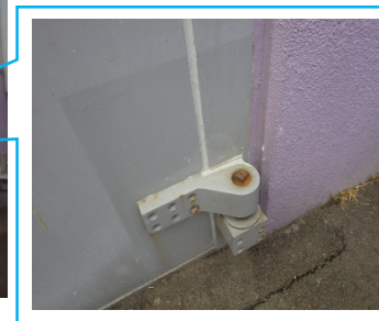
扉と枠の隙間を コーキング処理
