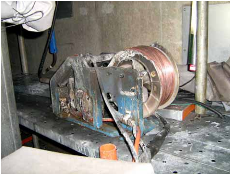
今回発煙のあった溶接棒の送り出し装置
