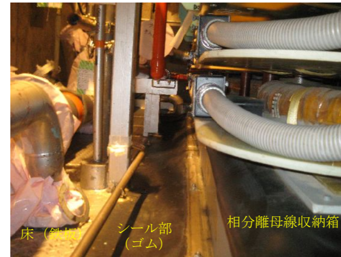
④相分離母線収納箱と床（鉄板）シール部（非管理区域） <相分離母線収納箱側>
