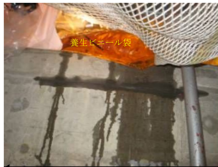
②発電機わき壁面
