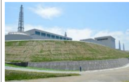
防潮堤 (5~7号機側)
