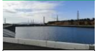
淡水貯水池設置
