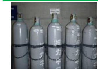
予備ポンベの配備
