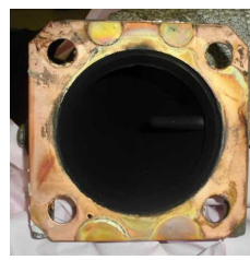
No.10シリンダ 出口排気管 (R側)
