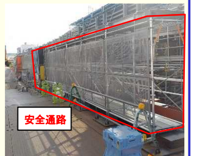
屋根付き安全通路の設置状況
