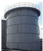
ALPS処理水タンク (フランジ型タンク) 水抜き・解体 (G4北、G5エリア)
