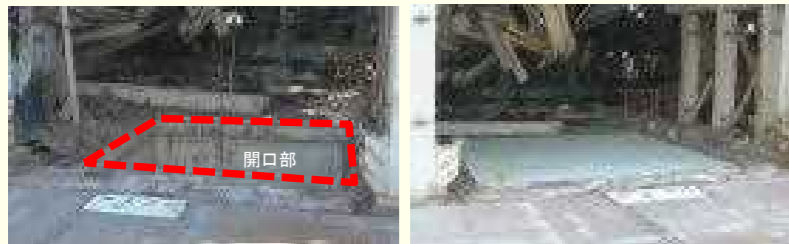
開口部養生カバー設置前 開口部養生カバー設置後
