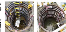
(陸側遮水壁) 内側 (陸側遮水壁) 外側
