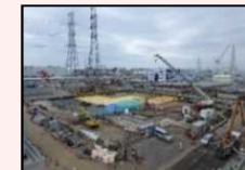
H1東エリア解体後の様子
