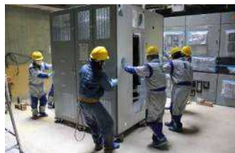
1号機 電源盤(P/C 1C-1)据付作業
