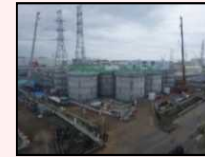
H1東エリア解体開始時の様子
