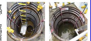
(陸側遮水壁) (陸側遮水壁) 内側 外側
