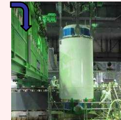
燃料取り出し状況
