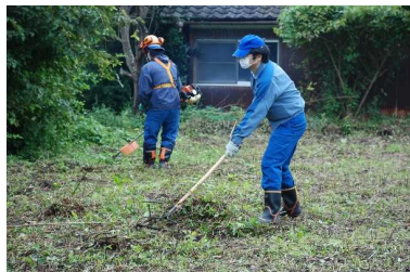
住宅進入路の除草
