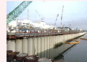
海側遮水壁 鋼管矢板打設完了状況
