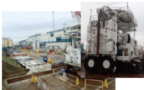
【6号機タービン建屋付近】
