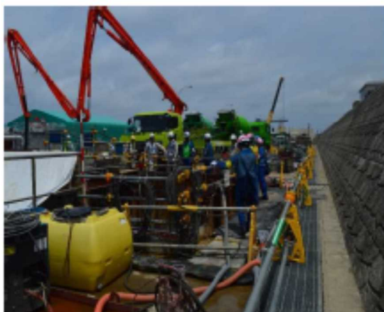
【7号機取水口付近】
