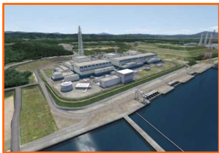
【柏崎刈羽原子力発電所】
