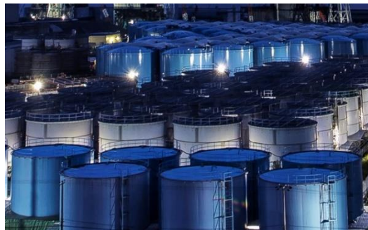
処理水貯蔵用タンク
