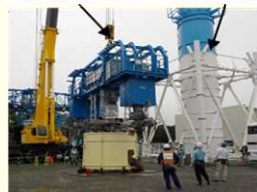
モックアップ試験の状況
