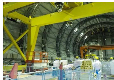
3号機 原子炉建屋オペレーティングフロアにおける試運転
