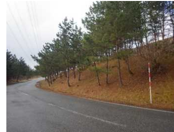
防火帯（整備前）
