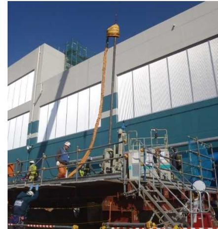
地中に高圧の空気、水、セメントミルクを噴射し、地中の砂を切削し、セメントミルクと混合・置換し、改良体を造成
