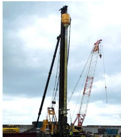
地中の砂とセメントミルクを機械的に攪拌、混合して、改良体を造成
