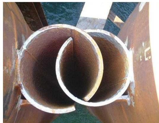
鋼管矢板と鋼管矢板の継手は、写真の隙間をモルタルで充填し、止水します
