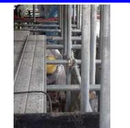
(凍結管バルブ開閉操作の様子)
