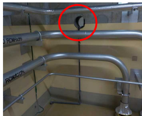
2号機原子炉建屋（管理区域） 地下1階
