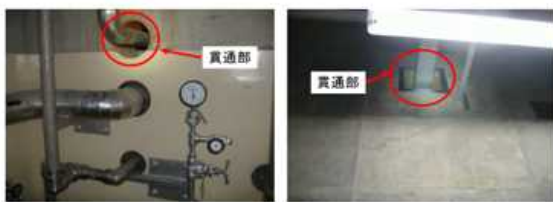
1/2号機サービス建屋 地下1階 (放射性廃棄物処理系サブポンプ室入口付近)
