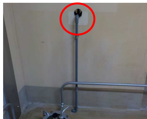
2号機原子炉建屋（管理区域） 地下5階
