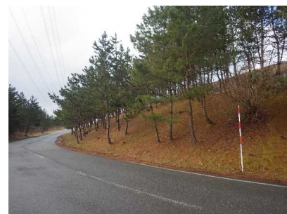
防火帯着手前
