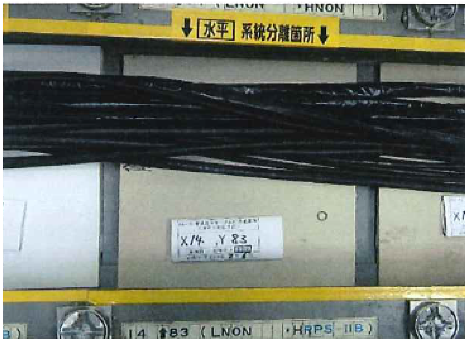
総点検後の状況(2017年2月6日撮影)
