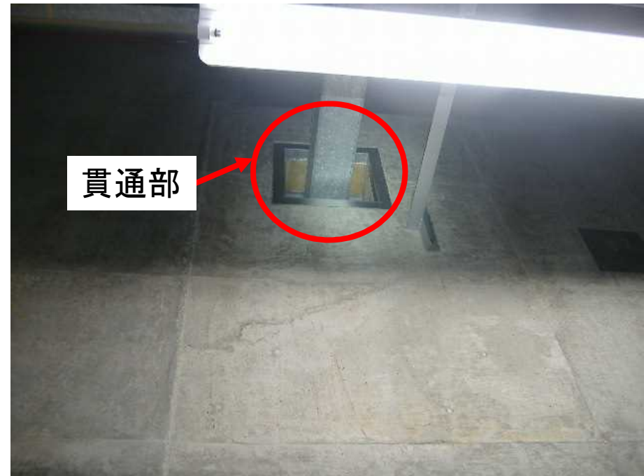
4号機原子炉建屋 地下5階 (通路)
