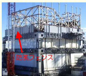
進捗状況（11/27撮影）
