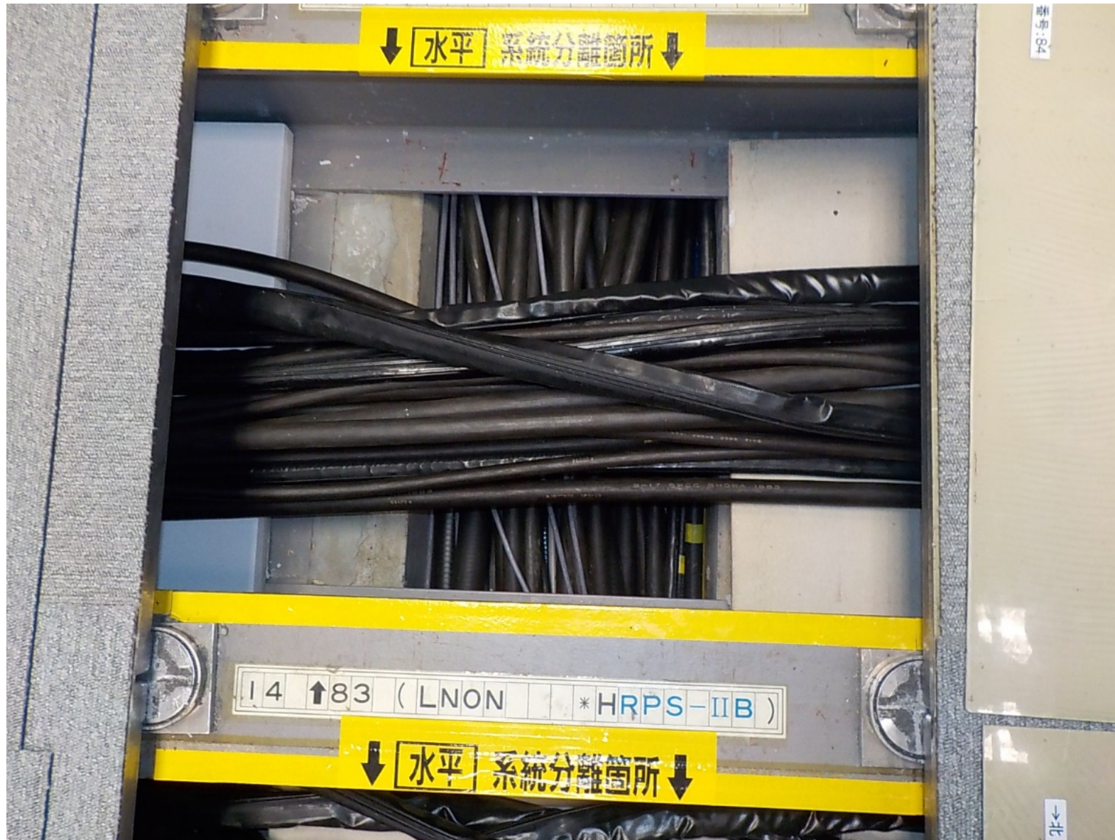
本日作業前の状況(2017年10月26日撮影)
