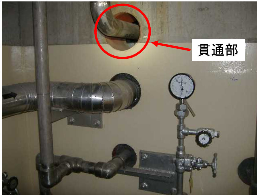
1/2号機サービス建屋 地下1階 (放射性廃棄物処理系サンプポンプ室入口付近)
