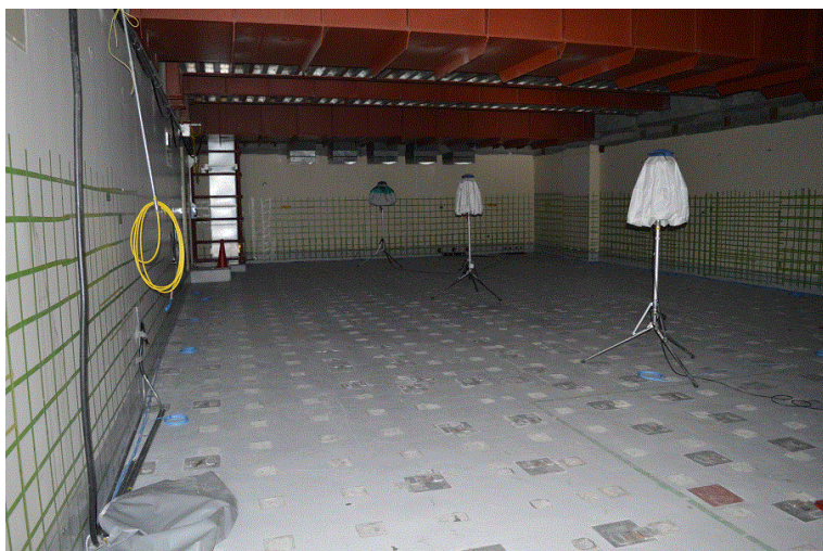
緊急時対策所の工事状況
