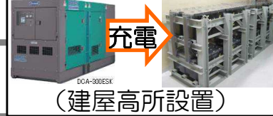
充電 DCA-300ESK (建屋高所設置)
