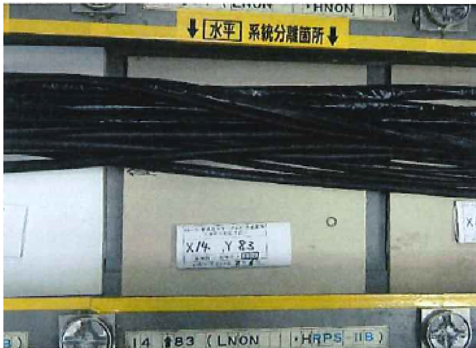
総点検後の状況(2017年2月6日撮影)
