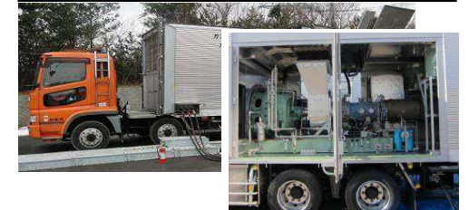
ガスタービン発電機車 (高台配備)
