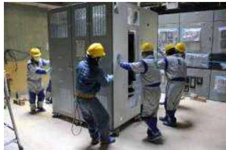
1号機 電源盤(P/C 1G-1)据付作業
