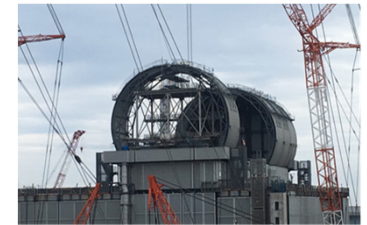
3号機燃料取り出し用カバー設置状況 (2017/10/25)
