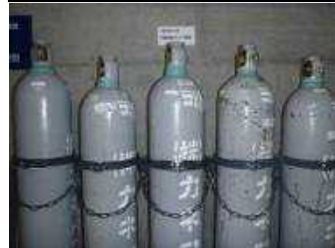
予備ポンベの配備
