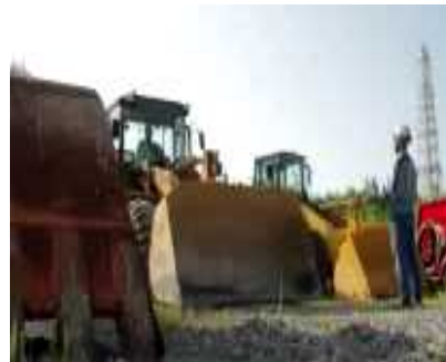
ガレキ撤去訓練
