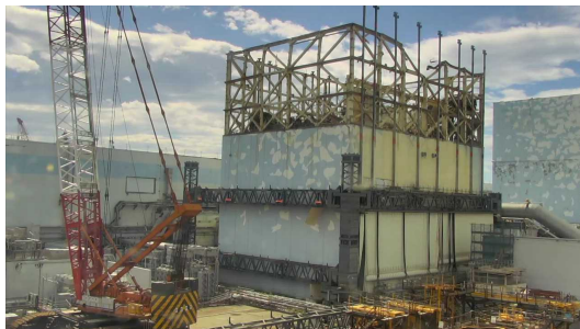
1号機 建屋カバー 柱・梁の取り外し完了 (5月11日)
