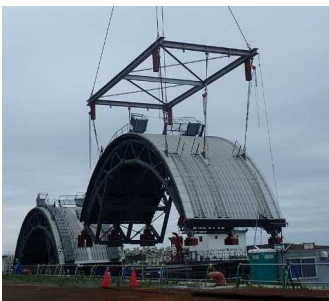
3号機 燃料取り出し用カバー搬入 (6月27日)
