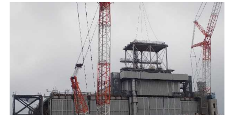
3号機燃料取り出し用カバー設置状況 (2017/7/26)
