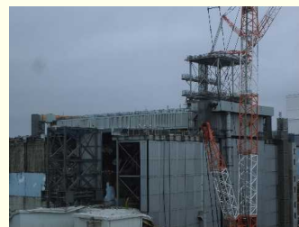
<ドーム屋根設置作業状況> (スライド架台設置)
