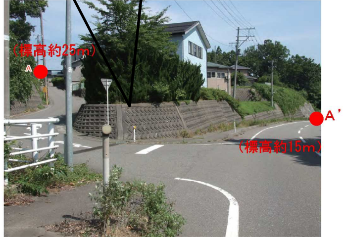
Loc. 54の現況写真 (2017.7撮影)
