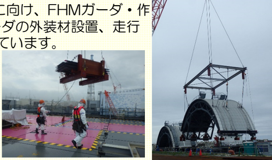
<3号機作業床上作業状況> <ドーム屋根構内搬入>
