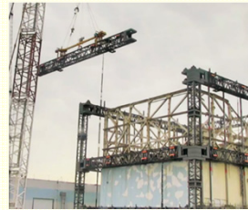
＜梁の取り外し作業の状況＞
