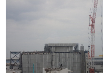
3号機燃料取り出し用カバー設置状況 FHMガーダ鉄骨部材設置状況
