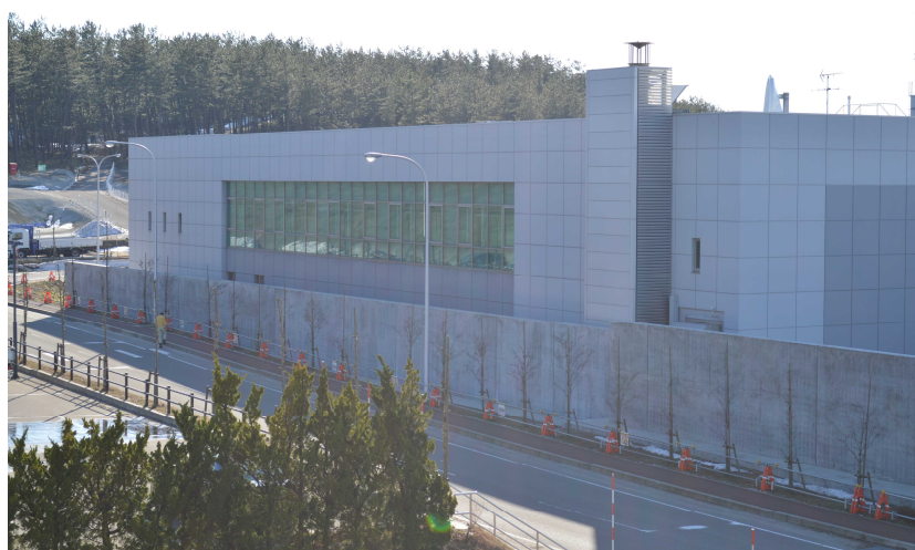
【免震重要棟外観】
