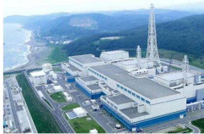
柏崎刈羽原子力発電所
