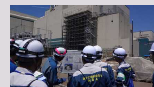
原子力規制委員会による現場確認（地上式フィルタバント）
