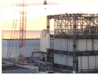
<壁パネル取外し状況>
