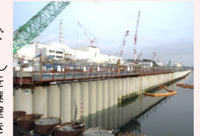
海側遮水壁 鋼管矢板打設完了状況
