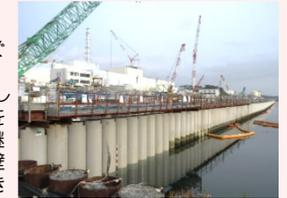
海側遮水壁 鋼管矢板打設完了状況
