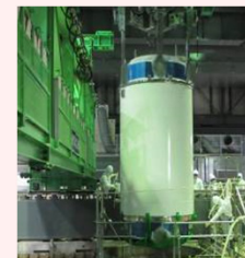
燃料取り出し状況
