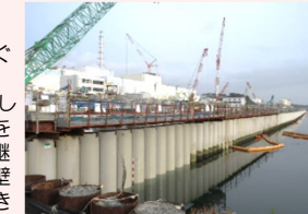
海側遮水壁 鋼管矢板打設完了状況
