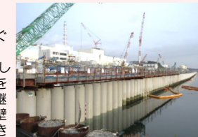
海側遮水壁 鋼管矢板打設完了状況
