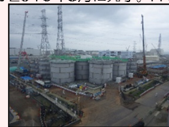
H1東エリア解体開始時の様子
