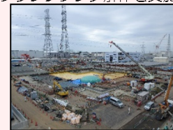
H1東エリア解体後の様子
