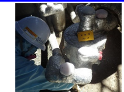
(凍結管への水の付着状況)
