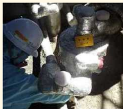
陸側遮水壁の凍結開始
