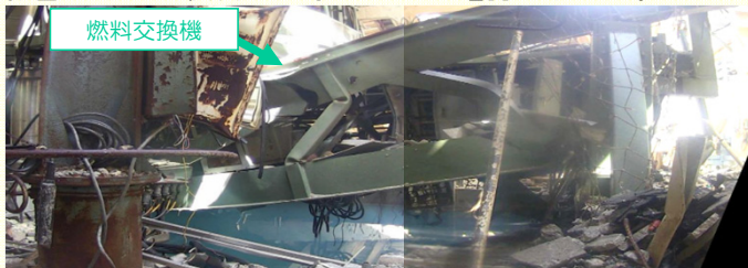
<原子炉建屋最上階ガレキ調査状況（燃料交換機南東部）>
