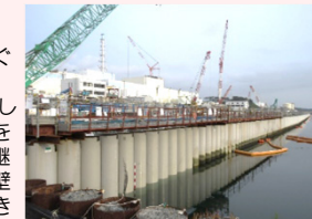
海側遮水壁 鋼管矢板打設完了状況
