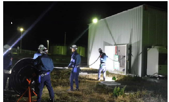
夜間のケーブル敷設訓練
