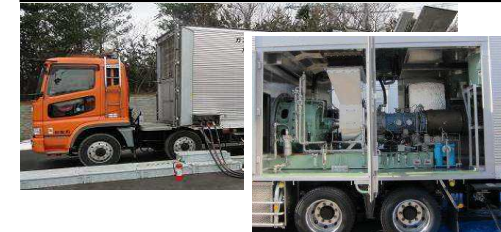
ガスタービン発電機車 (高台配備)
