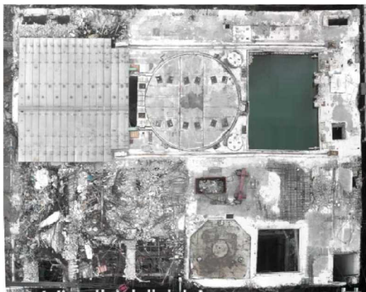
3号機オペフロ瓦礫撤去状況
