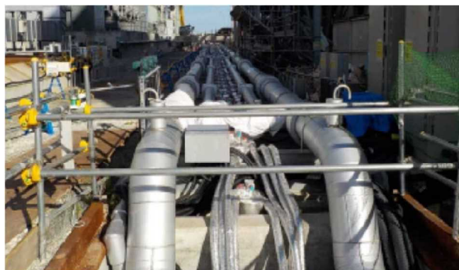
陸側遮水壁設置状況
