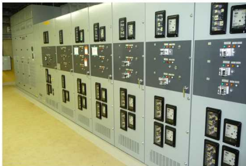
1号機 電源盤 (P/C 1C-1) 据付後
