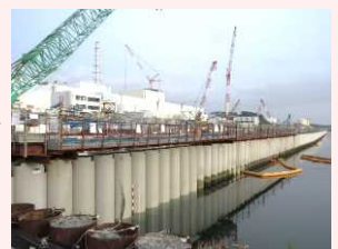
海側遮水壁 鋼管矢板打設完了状況
