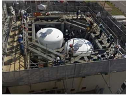
追加設置されたヨウ素フィルタ (無機および有機ヨウ素除去)
