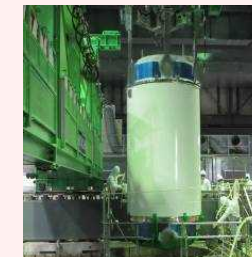
燃料取り出し状況
