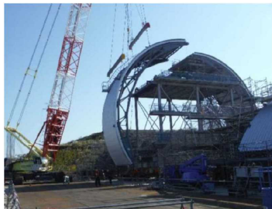
3号機燃料取出用カバー 組み立て訓練状況
