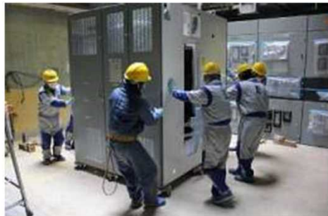
1号機 電源盤 (P/C 1C-1) 据付作業
