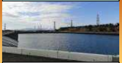
淡水貯水池設置
