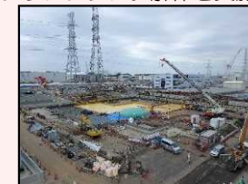
H1東エリア解体後の様子
