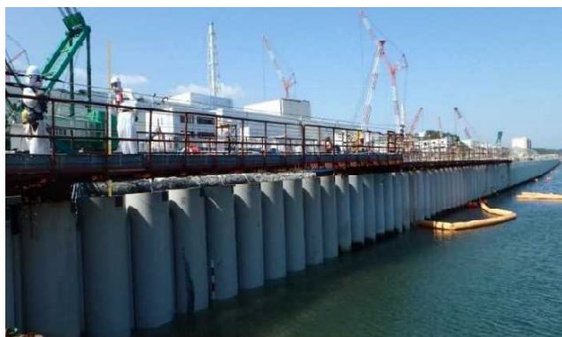
海側遮水壁設置状況
