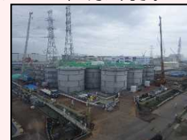
H1東エリア解体開始時の様子
