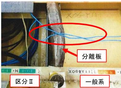
6号機 水平分離板の隙間を貫通
