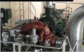
原子炉隔離時冷却系
