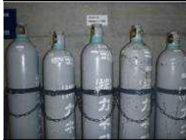
予備ポンベの配備
