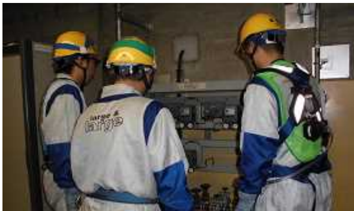
当社社員（右）による作業現場確認の様子
