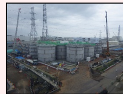
解体開始時の様子
