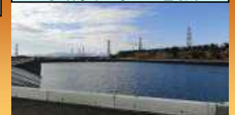
淡水貯水池設置
