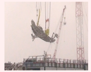
8/2 燃料交換機撤去作業の様子
