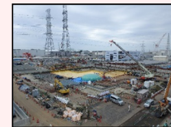
解体後の様子
