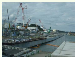
海側遮水壁矢板打設作業の再開
