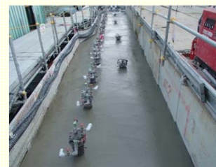
<陸側遮水壁海側 凍結管設置状況>
