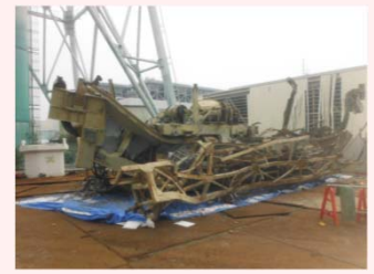
撤去した燃料交換機
