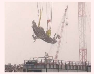
8/2 燃料交換機撤去作業の様子
