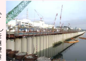
海側遮水壁 鋼管矢板打設完了状況
