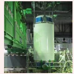
燃料取り出し状況
