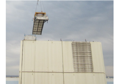
(1号機建屋カバー解体作業の状況)
