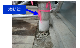
(陸側遮水壁 試験凍結箇所例)
