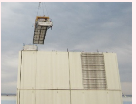
屋根パネル取り外し状況
