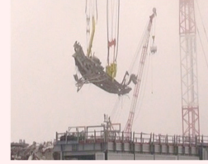
8/2 燃料交換機撤去作業の様子
