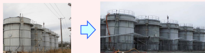
堰カバー設置前
