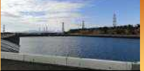
淡水貯水池設置
