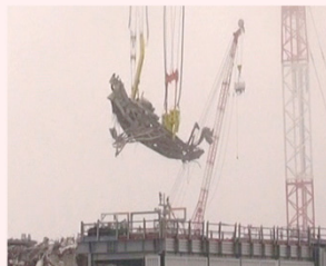
8/2 燃料交換機撤去作業の様子
