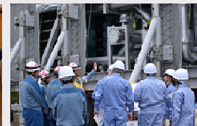
安全対策設備の確認（代替熱交換器車）
