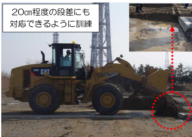
ホイールローダによる段差箇所の補修訓練の様子
