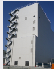
大型休憩所外観
