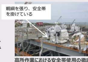
高所作業における安全帯使用の徹底
