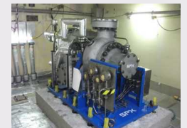
高圧代替注水系（注水機能強化）設置工事
