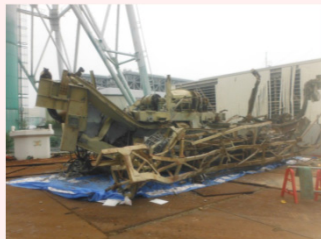
撤去した燃料交換機
