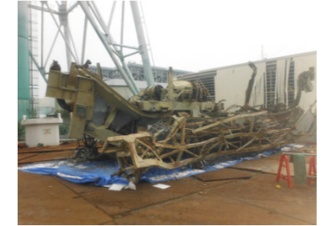
(8/21に撤去した燃料交換機)
