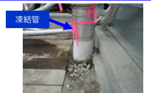
(陸側遮水壁 試験凍結箇所例)
