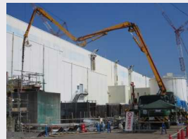
2号機海水配管トレンチ内の充填作業
