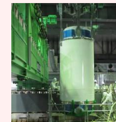
燃料取り出し状況
