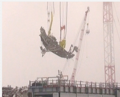
＜燃料交換機撤去作業の状況＞
