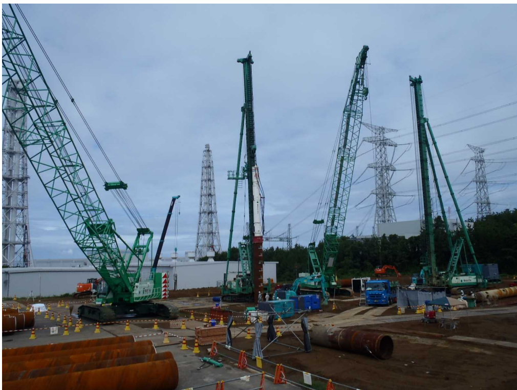
移設場所の杭打ち作業の様子
