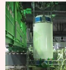
燃料取り出し作業開始から1年以内となる2014/11/5に、プール内の使用済燃料1,331体の共用プールへの移送が完了した。残りの新燃料の6号機使用済燃料プールへの移送は、2014/12/22に完了。（新燃料2体については燃料調査のため2012/7に先行して取り出し済）
