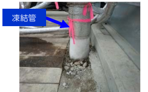
(陸側遮水壁 試験凍結箇所例)
