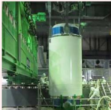
燃料取り出し状況
