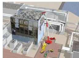
原子炉建屋上部のガレキ撤去
