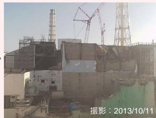
大型ガレキ撤去後
