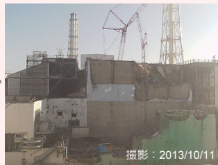
大型ガレキ撤去後
