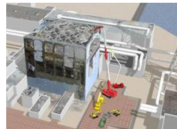
原子炉建屋上部のガレキ撤去
