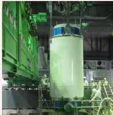
燃料取り出し状況
