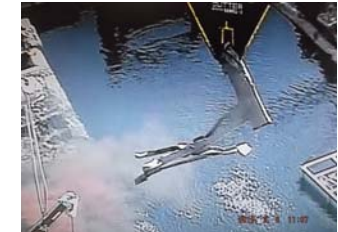
(3/6: 燃料交換機西側フレーム撤去作業状況)
