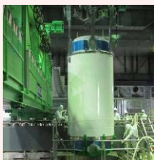
燃料取り出し状況
