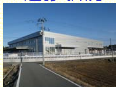
<給食センター外観>
