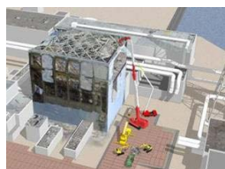
原子炉建屋上部のガレキ撤去
