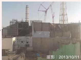
大型ガレキ撤去後
