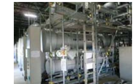
(陸側遮水壁 凍結プラント設置状況)
