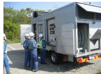
✓ 電源車接続訓練
