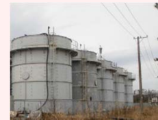
堰カバー設置前
