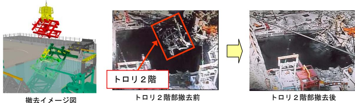
図8：3号機使用済燃料プールガレキ撤去状況
