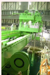
燃料取り出し状況
