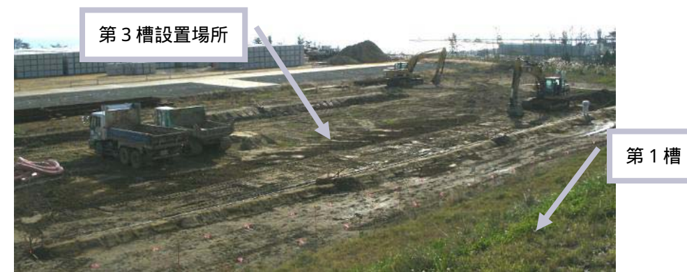
図11：覆土式一時保管施設 第3槽設置エリアの掘削状況
