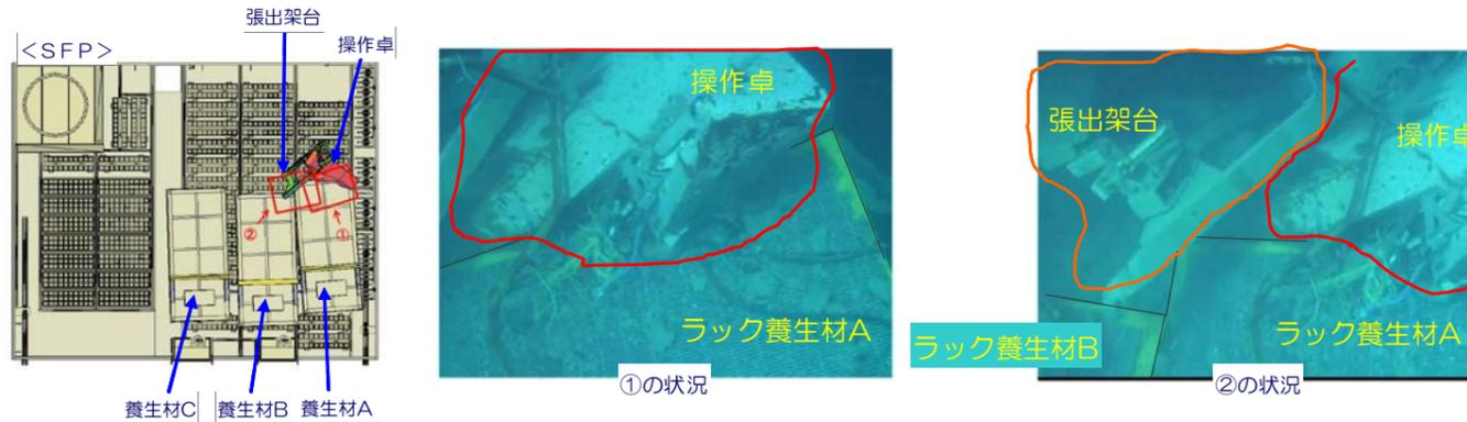
図11：操作卓及び張出架台 落下現場状況
